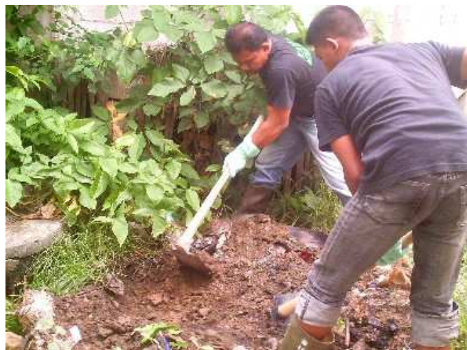
Penggalian Lubang Pembuangan Lumpur / Prepare Sludge Dumping Site
